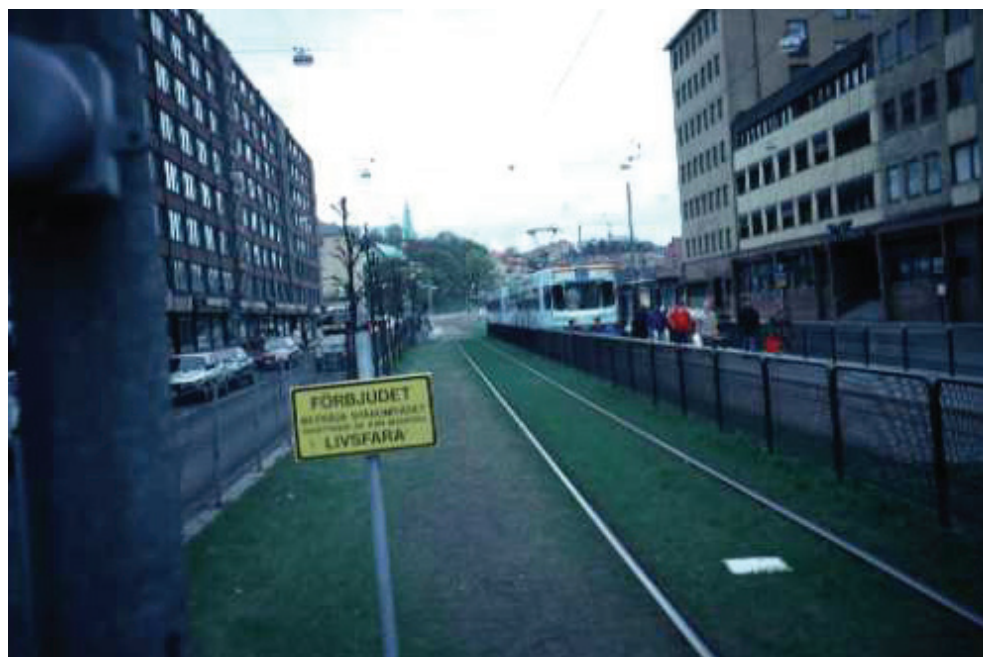
Sikring av holdeplasser og sporområder med gjerde (Gøteborg).
