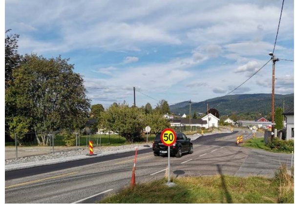
Figur 1.2: Situasjonsbilde fra fv. 2382 ved tidspunkt for førundersøkelse.
