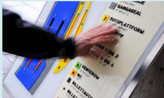
Figur 14 Informasjonstavle med både taktile bokstaver og braille. Ikke alle blinde leser braille. Foto: Knut Opeide. Statens Vegvesen
