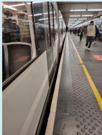
Figur 25 Det er viktig med glipefrie adkomst mellom transportmiddel og perrong. Taktile varselmarkering ses også på bildet. Her fra Oslo S.
