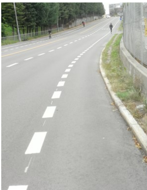
Figur V1.7: Fristende snarvei for gående mellom Birkebeingata og bussholdeplassen i øst (vestgående retning).
