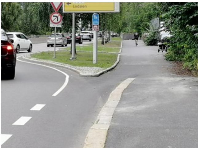
Figur V1.5: Utydelig overgang fra sykkelfelt til GS-veg i øst. .
