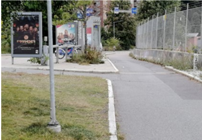
Figur V1.6: Uklar overgang fra GS-veg til sykkelfelt ved bussholdeplassen i øst (vestgående retning).
