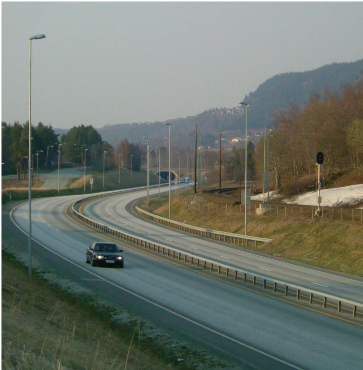
Bilde 1: Nye E6 sør for Trondheim ved Søberg med midtrekkverk og tilgivende sideterreng. Gamle E6 sees til opp til venstre i bildet og viser kontrasten mellom den gamle og den nye veggen.
