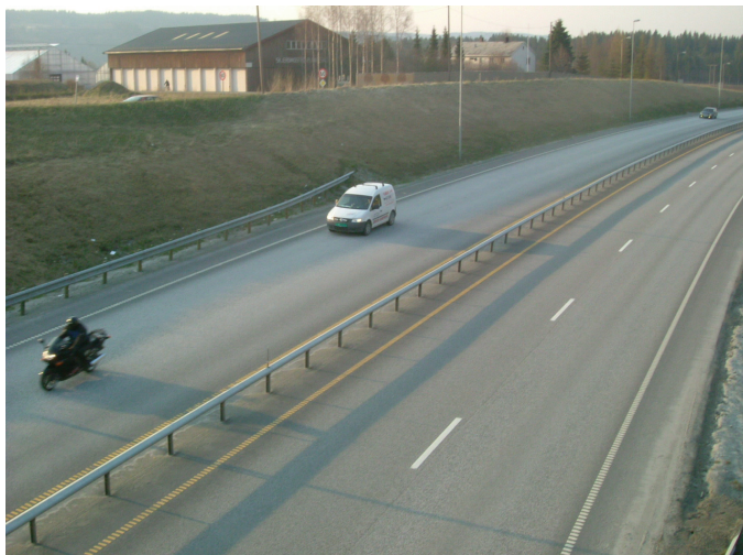
Bilde 2: Midtrekkverk uten skinne nederst som ville beskytte motorsyklister bedre ved uhell.
