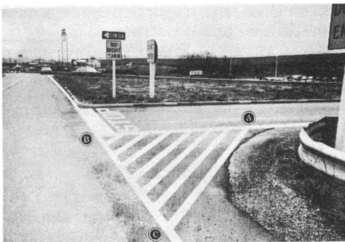
Figur 4.4. Eksempel på oppmerking som skal motvirke at bilister kjører mot kjøreretningen på avsvingingsrampen. (Kilde: Vaswani, 1974)
