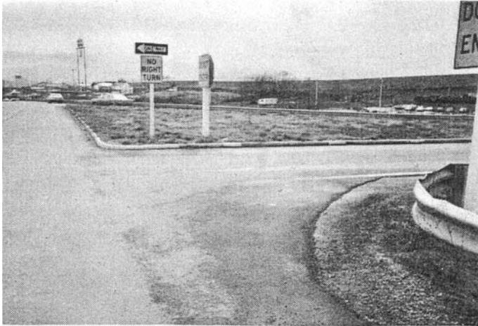
Figur 4.3. Avkjøringsrampe (vegen fra høyre på bildet) med avrundet hjørne, noe som kan mislede bilister på sekundervegen til feilaktig avsvinging mot høyre. (Kilde: Vaswani, 1974)
