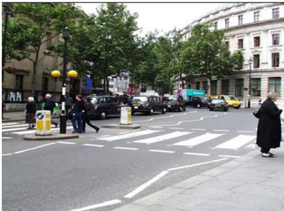
Figur 2.30: Sikksakkoppmerking for å gi inntrykk av smalere kjørefelt i Storbritannia og Irland. Kilde: Fitzpatrick et al.(2003).
