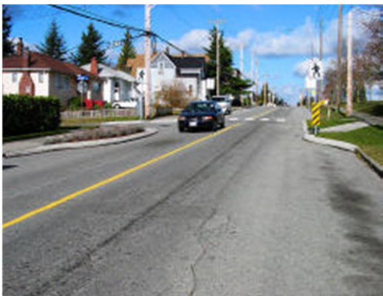
Figur 2.10: Utvidet fortau med kantstein i Lanark County, Canada. Kilde: AECOM Canada Ltd. (2009).
