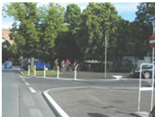
Figur 2.4: Fortausutvidelse i kryss uten oppmerket gangfelt i Østerrike. Kilde: Lokale Agende 21 Wien, http://la21wien.at/ .
