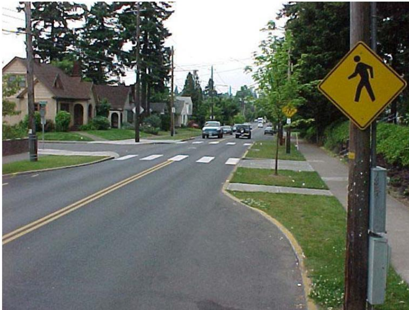
Figur 2.11: Gate med utvidet fortau ved gangfelt i British Columbia, Canada. Kilde: Murphy (2003).
