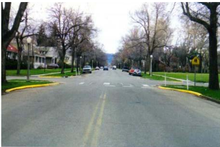
Figur 2.9: Utvidet fortau med kantstein i flere engelskspråklige land. Kilde: Fitzpatrick et al. (2003).
