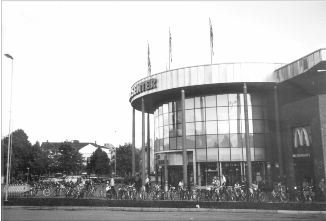
Figur 3.5 Inngangspartiet til Ski storsenter sett fra jernbanestasjonen.
