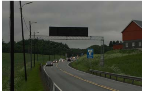
Teksttavle ved Storler med reisetidsinformasjon og hendelsesvarsling
