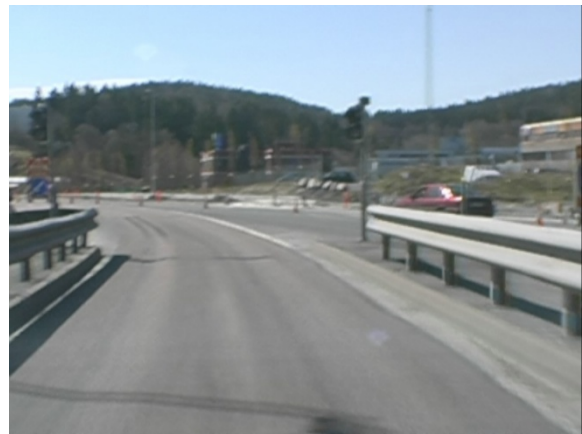
10. Bil fra høyre ved innsnevring av kjørebanelen etter passering av bomstasjon.
